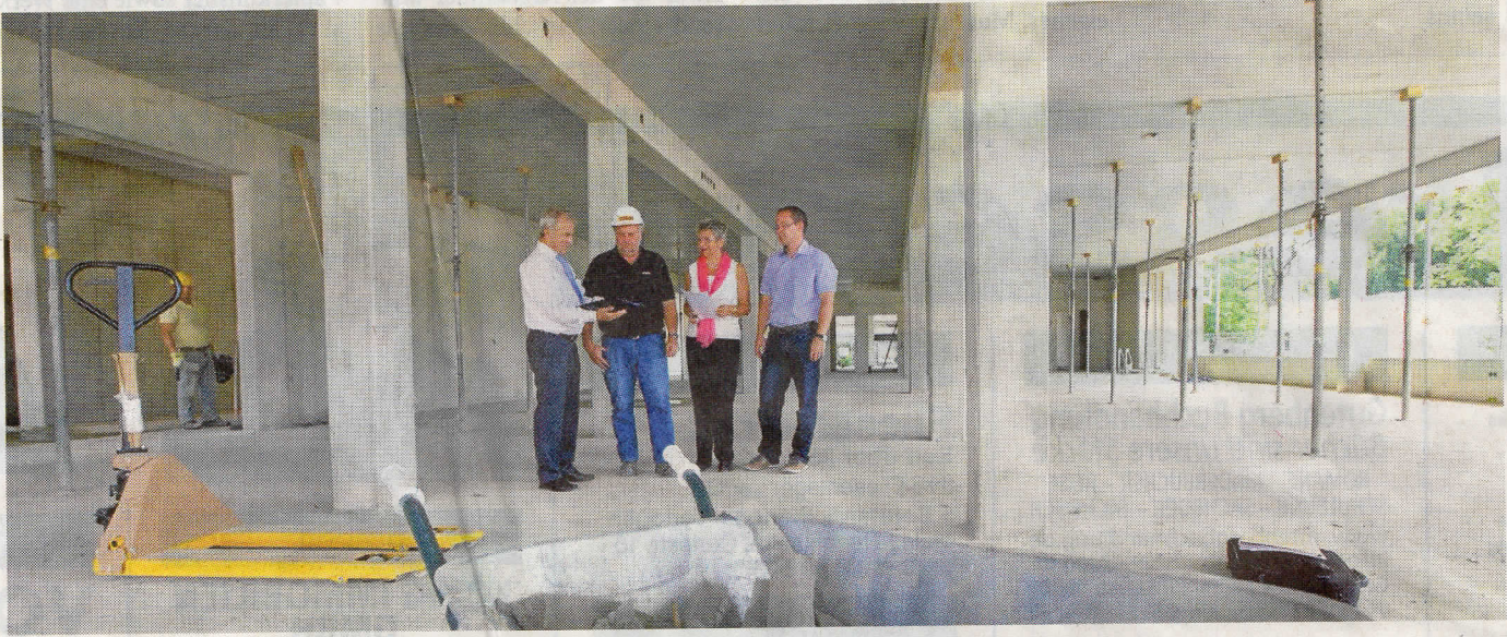
Landrat Claus Schick, Polier Alban Hoffmann, Schulleiterin Helga Lerch und Steffen Wolf von der Schulabteilung des Kreises begutachten den Neubau, der Teil des Nackenheimer Gymnasiums ist. Foto: hzb/Michael Bahr
